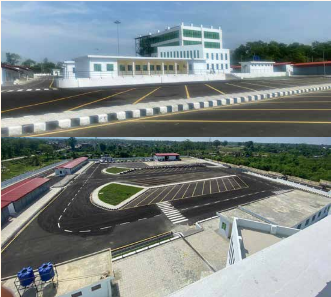
कोहलपुर नगरपालिकामा शहरी पूर्वाधार विकास आयोजना अन्तर्गत निर्माण सम्पन्न कोहलपुर क्षेत्रीय वसपार्क
