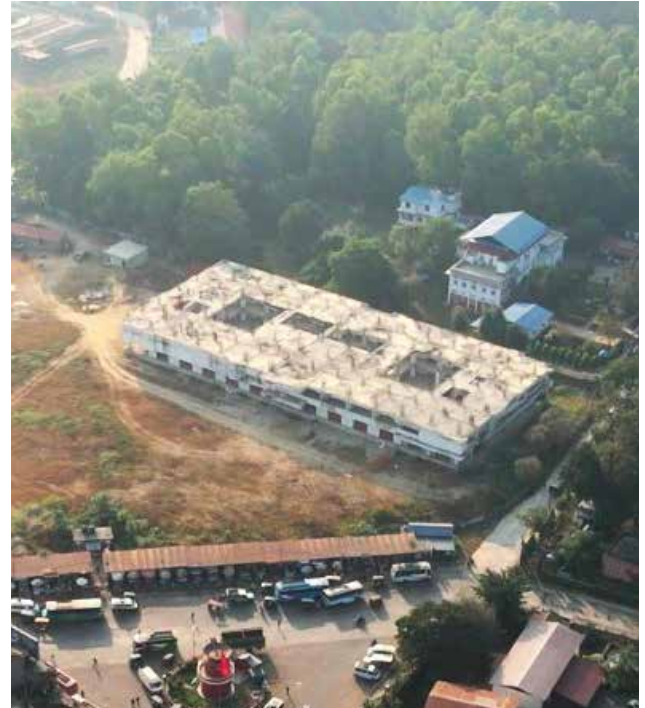
(शहरी पूर्वाधार विकास आयोजनाअन्तर्गत हेटौँडा उपमहानगरपालिकामा निर्माणाधीन हेटौँडा बस टर्मिनल भवन आयोजना)
