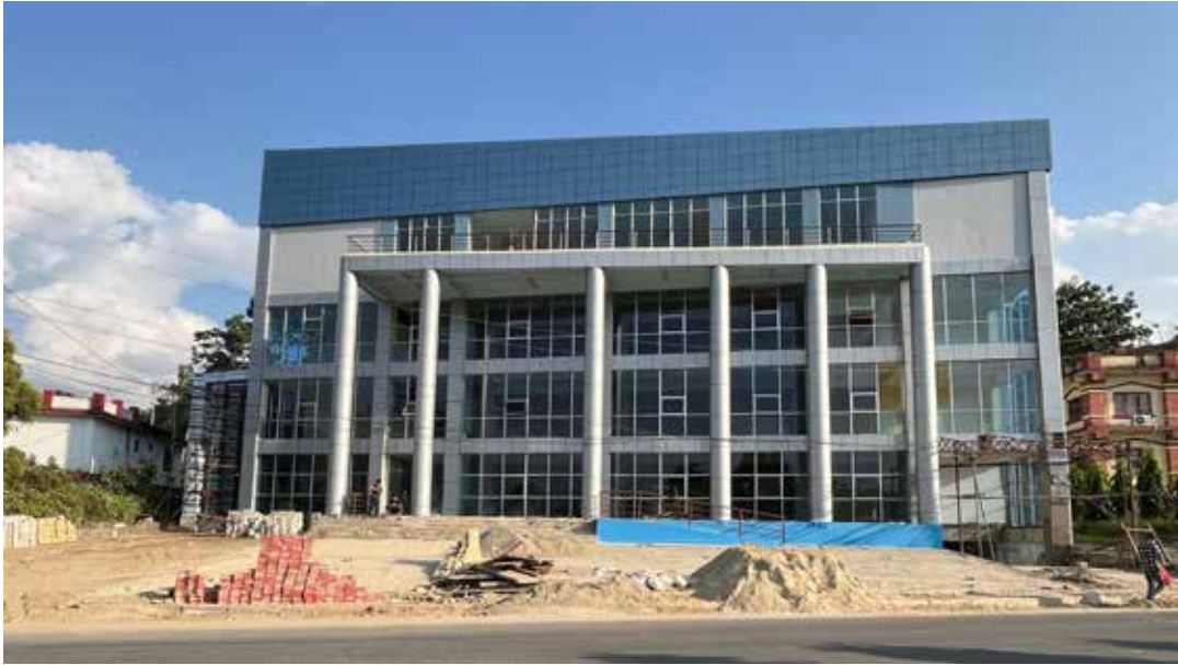
(शहरी पूर्वाधार विकास आयोजनाअन्तर्गत कमलामाई नगरपालिकामा निर्माणाधीन सभाहल)
